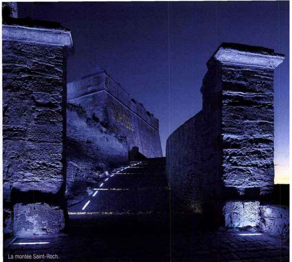
La lumière encastrée au sol pulse selon les battements d'un cœur.
